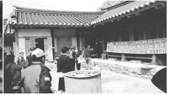
복원중인 청문당 안채 전경
